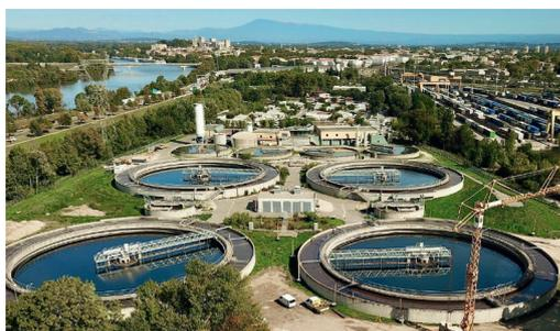
L'usine de méthanisation de la station d'épuration de Courtine est désormais opérationnelle. C'est une véritable avancée dans le champ des énergies renouvelables du territoire. Grâce à ce nouvel équipement, une partie des déchets est exploitée pour produire du biogaz. Le volume des sorties de boues est ainsi réduit de 30%. Le biométhane obtenu est injecté dans le réseau de distribution de gaz naturel GRDF.
